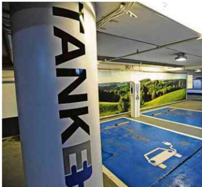
Elektro-Tankstelle der EVL in der Tiefgarage an der Friedrich-Ebert-Straße unter der Wiesdorfer City C. Foto: Britta Berg
