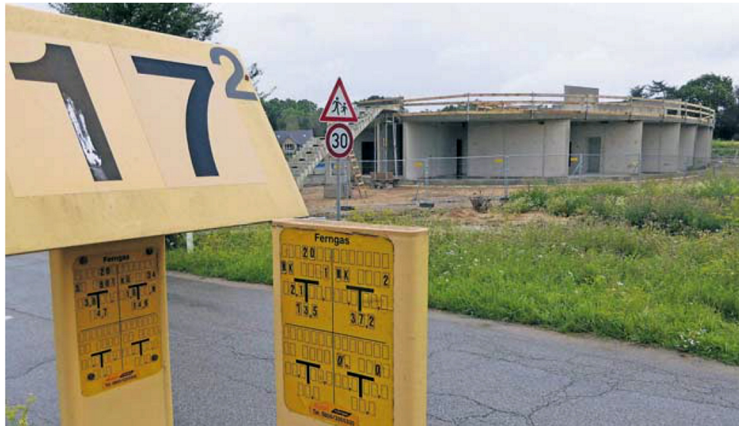
Wie unser Fotograf gestern dokumentierte, liegt eine Hochdruckgasleitung ebenfalls in unmittelbarer Nähe der fertigen Kindertagesstätte von Lanxess und nahe der Kita-Baustelle von Bayer am Kurtekottenweg in Wiesdorf.
