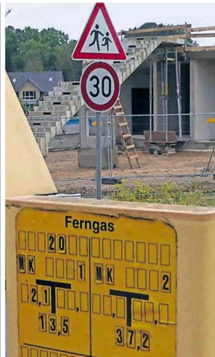
Nur eine Straßenbreite entfernt vom neuen Bayer-Kindergarten verläuft am Kurtekotten eine Hochdruck-Ferngasleitung. Einen Grund, deshalb die Kita nicht zu bauen, sieht der Konzern nicht.
